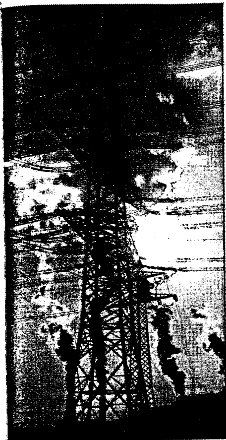
Hochspannungsmast und RWE-Kraftwerk bei Köln: Künftig wird alles komplizierter.
